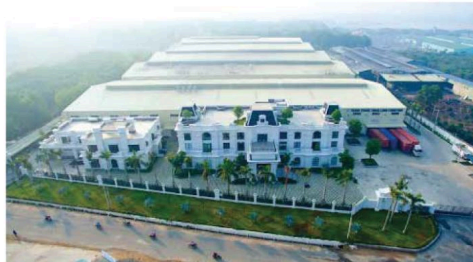
KHU CÔNG NGHIỆP GILIMEX
